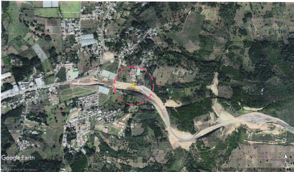
Figura No. 1 Localización del área afectada.
