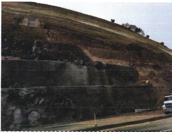
Imagen No. 1, Sistema de bermas con recubrimiento en la base.
